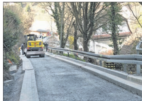
Die erste Tragschicht im aktuellen Bauabschnitt der Gimbacher Straße liegt. Rechtzeitig vor Ostern soll die Straße wieder freigegeben werden.
