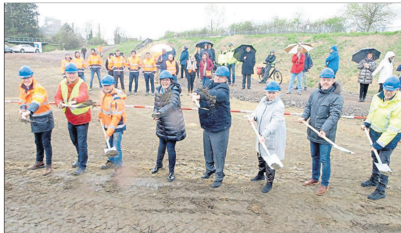
Gute Stimmung trotz schlechtem Wetter beim ersten Spatenstich für die neue Brücke.
