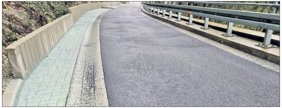
Im zweiten Bauabschnitt der Gimbacher Straße wurden der gesamte Unterbau der Straße erneuert, aber auch Ausweichbuchten angelegt. Foto: Stadt Eppstein
