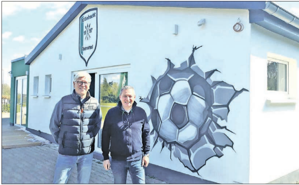
Der Ball ist voll eingeschlagen in der Wand und dem Vereinswappen über der Tür. Architekt Robin Weber, der die Bauplanung und Bauleitung ehrenamtlich übernommen hat, und Kassierer und Finanzchef Udo Peschke (v. l.) haben das gesamte Projekt operativ gewuppt. Foto: js
