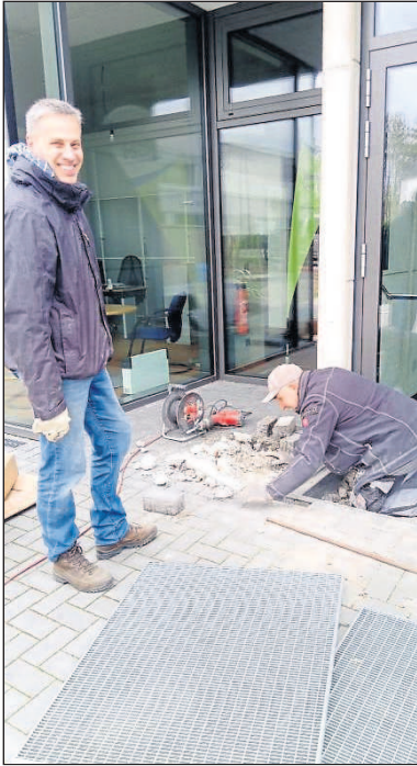
Die Herren bei der Betonarbeit.
