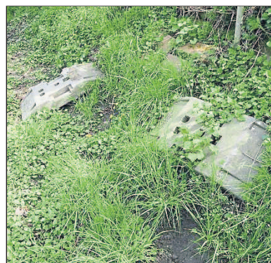
Standfüße im Grabenbereich.
