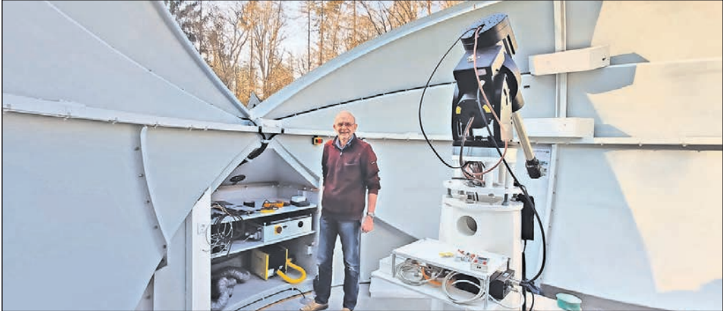
2. Vorsitzender und Bauleiter Bernhard Strauch erledigt letzte Elektroarbeiten in der geöffneten AllSky-Kuppel. Das Teleskop fehlt noch, wird aber schon bald montiert. Foto: R. Jäger
