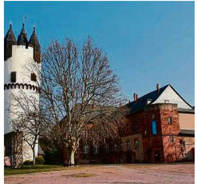
Malerischer Blick auf Schloss Steinheim: Im Museumsgebäude (rechts) leckt allerdings das Dach. FOTO: KATRIN STASSIG
