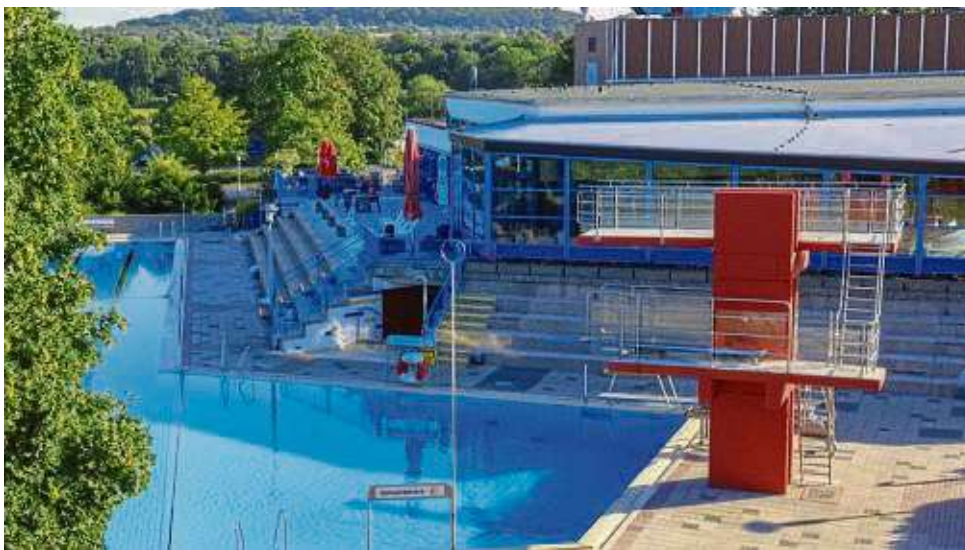
Noch ein letztes Jubiläum: Nach der Sommersaison 2024 soll das Maintalbad abgerissen werden. Das 1974 angefügte Freibad ist dann 50 Jahre alt. Das Hallenbad wurde bereits 1973 errichtet.
