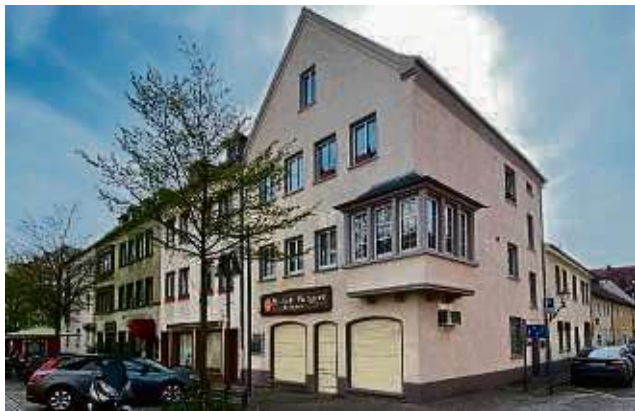
Sanierungsbedürftig ist das Gebäude der ehemaligen Metzgerei Kober. Um die denkmalgerechte Instandsetzung soll sich die Baugesellschaft kümmern. FOTO: REINHARD PAUL
