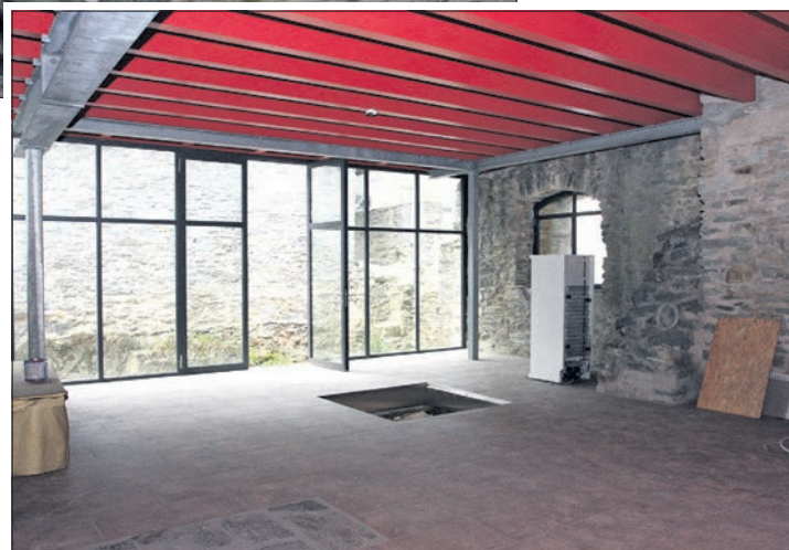
Auch der Juchhe-Bau der Burgschauspieler ist noch Baustelle, die Stromanschlüsse müssen noch verlegt und das Sichtfenster im Fußboden zum historischen Untergrund beleuchtet werden. Die Glasabdeckung ist fertig. Fotos: Beate Schuchard-Palmert
