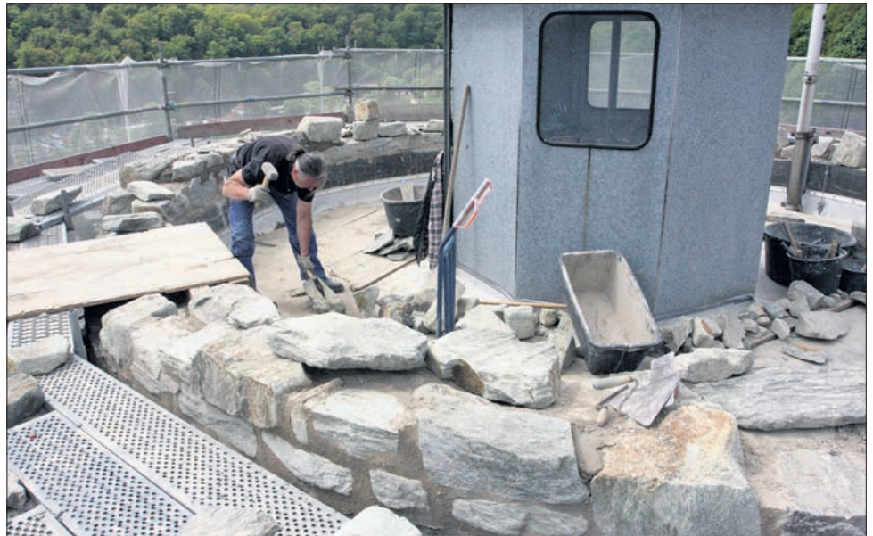
Steinmetz Michael Grimm bearbeitet einen Naturstein, Serazitgneis aus dem Steinbruch in Fischbach, für die Mauerbrüstung. Fotos: Beate Schuchard-Palmert
