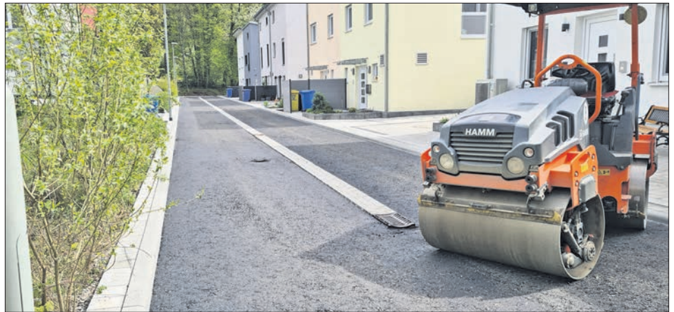
Letzter Feinschliff In den Amtmannswiesen – der Straßenbelag wurde nun endgültig fertiggestellt. Foto: Stadt Eppstein
