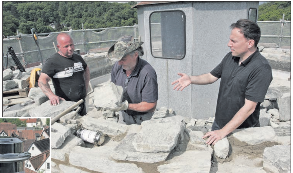
Fuhrunternehmer Martin Burkhard, Maurermeister Michael Grimm und Bürgermeister Alexander Simon setzen gemeinsam den Schlussstein. Fotos: bpa
