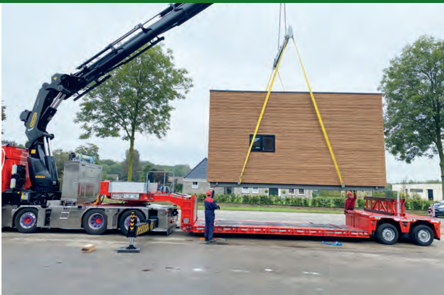
Lichte Bodenhöhe fünf Zentimeter: Der Auflieger hat eine Materialstärke von 20 Zentimetern.
