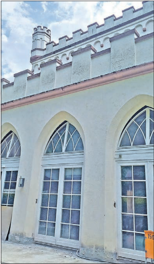
Es gibt noch viel zu tun auf der Baustelle Gotisches Haus. Auf der Südseite wird der neue Haupteingang eingerichtet, mit direktem Zugang zum Café mit Außenbewirtschaftung im Garten. Foto: js
