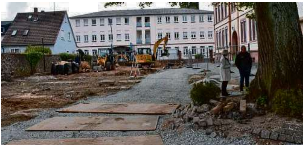
Wo sonst Kinder spielen, sind vorerst die Bagger zugange: Der Schulhof der Geschwister-Scholl-Schule in Steinheim wird neu gestaltet.
