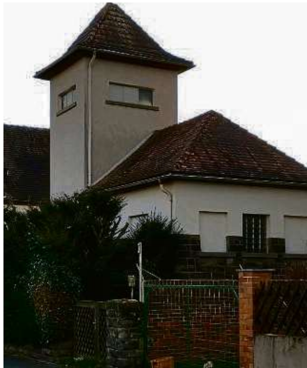
Das Umspannwerk am Ende der Kolpingstraße steht heute noch. FOTO: HGV
