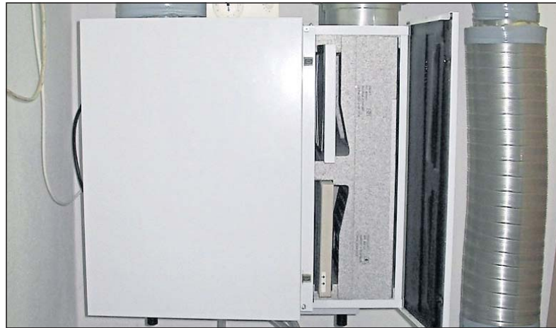
Lüftungsgerät mit zusätzlicher Wärmerückgewinnung. (Foto: VZ RLP/Bernhard Andre)
