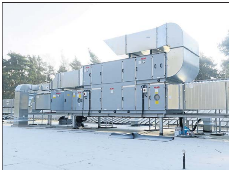
...und auf dem Dach.
