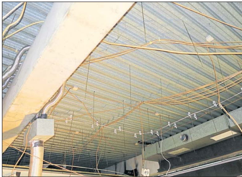
In der Cafeteria wurden Arbeiten bis hin zum Dach vorgenommen.
