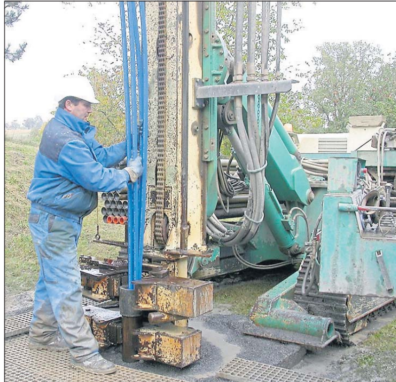
Erdreich oder Grundwasser sind als Wärmequelle für Wärmepumpen die erste Wahl. Dafür sind Bohrungen erforderlich, die bis zu 100 Meter in die Tiefe reichen können. (Foto: VZ-RLP)
