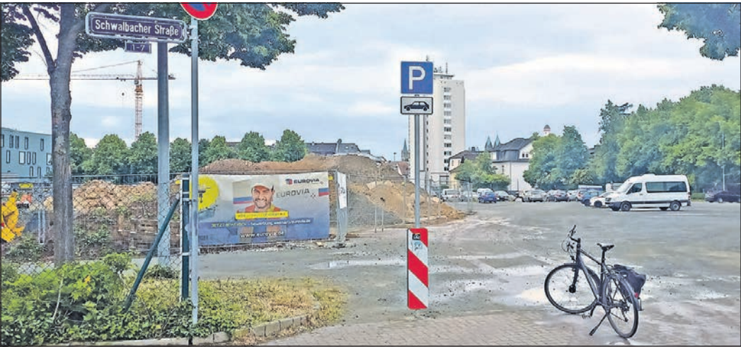
Zugang und Zufahrt zum Festplatz am Heuchelbach sind wieder gefahrlos möglich. Foto: js
