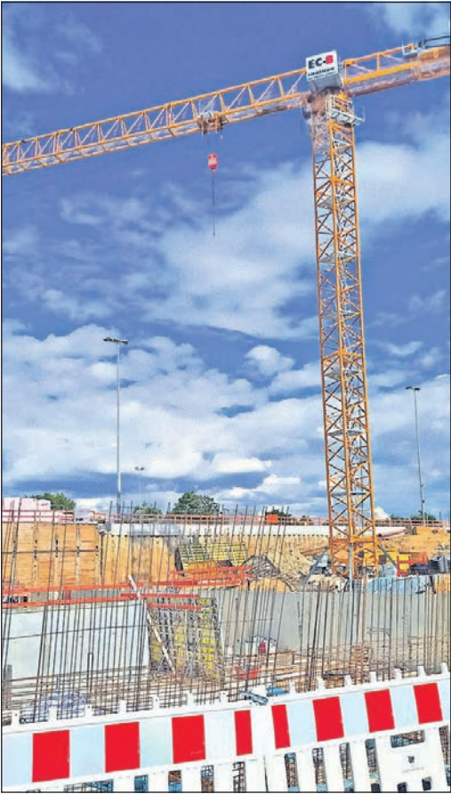
Ein riesiger Kran überragt die riesige Baustelle: Die Bodenplatte ist fertig, die ersten Seitenwände sind gestellt, am Massenheimer Weg wächst die doppelte Dreifeld-Sporthalle in den Eschbacher Himmel. Ende 2023 soll hier Sport getrieben werden. Foto: js
