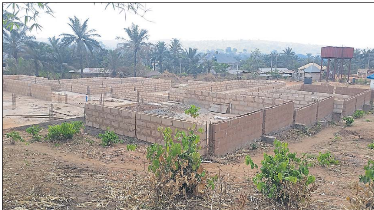
Der Bau der Schule in Ebe/Nigeria kommt gut voran – das Fundament steht, der Fußbodenausbau ist erledigt.
