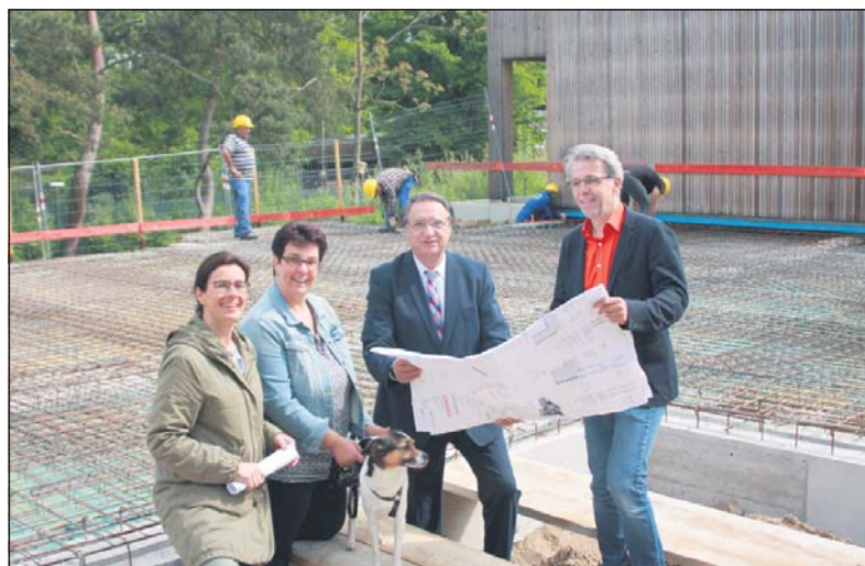
Kita-Leiterin Sonja Wagner und Bürgermeister Rainer Becker (beide in der Mitte) lassen sich von Bauleiterin Martina Acker und Architekt Winfried Klein auf den aktuellen Stand der Baumaßnahme bringen.
