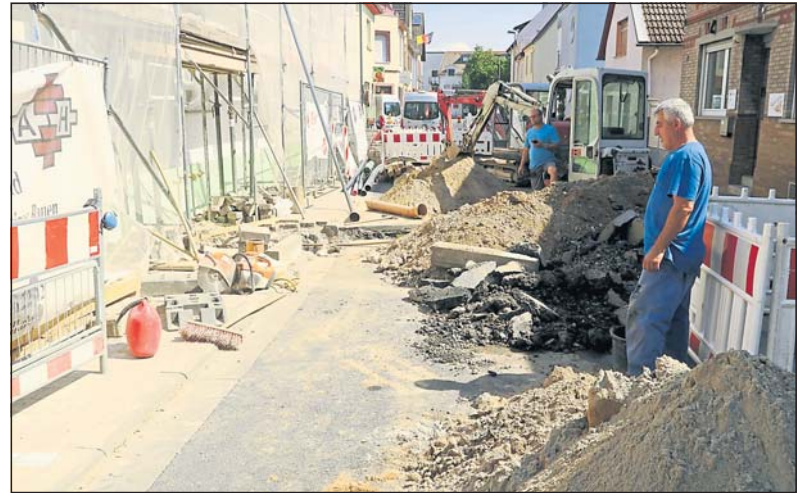
Die Arbeiten in der Binger Straße liegen im Zeitplan.
