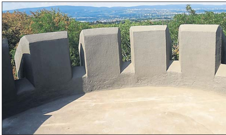
Die erneuerte Mauerzinne auf dem Lennebergturnm.
