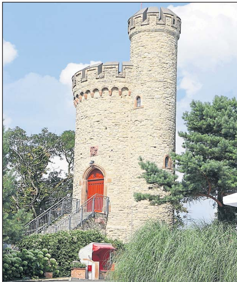
Der Lennebergturnm erstrahlt in neuem Glanz.
