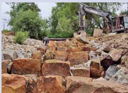
Die ersten Rampen werden gesetzt
