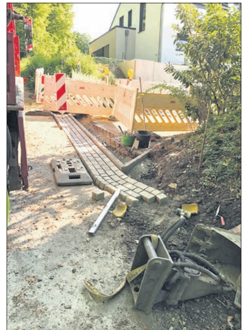
In Niederjosbach wurde eine Rinne zur Wasserführung als Schutzmaßnahme bei Starkregen angelegt. Foto: Stadt Eppstein
