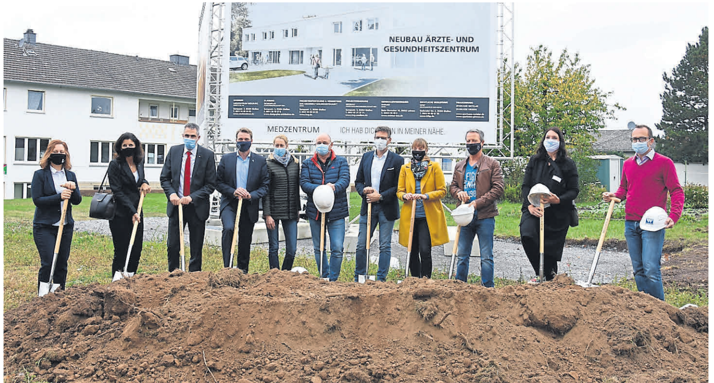
Die Beteiligten kurz vor dem ersten Spatenstich.
