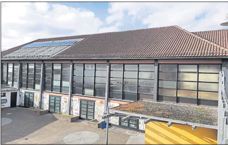
In Budenheim gibt es noch einige Dächer auf öffentlichen Gebäuden, die für Sonnenenergie-Nutzung gut geeignet sind. Wie beispielsweise dieses Schuldach. (Foto: Josef Dechent)
