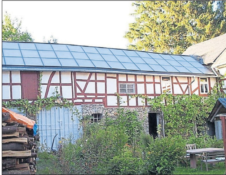
Eine Solaranlage für Warmwasser- und Heizungsunterstützung ist nicht für jeden Haushalt und jedes Dach geeignet. Bei diesem Fachwerkbau, der zusätzlich mit Holz geheizt wird, hat sich die Investition gelohnt. (Foto: VZ RLP/H. Kitzerow)
