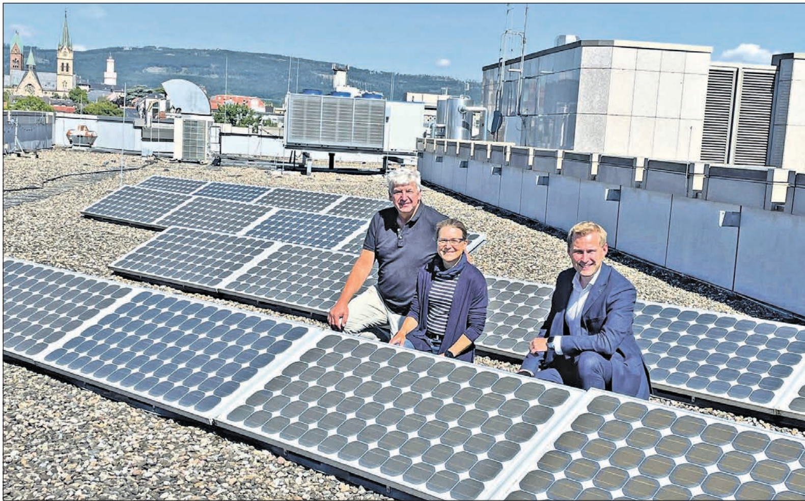
Photovoltaikanlagen wie diese auf dem Dach des Rathauses sollen zum Standard werden. Das ist der Wunsch von Claudia Richter und Holger Fröhlich vom Fachbereich Klimaschutz, Umwelt und Mobilität sowie von Bürgermeister Dr. Oliver Jedynek (v. l.). Foto: Stadt Bad Homburg
