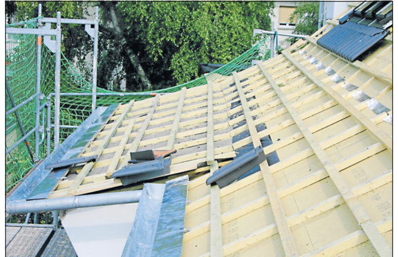
Holzweichfaserplatten sind eine empfehlenswerte Alternative zur Unterspännbahn: Sie sind stabiler und bieten einen zusätzlichen Dämmeffekt. (Foto: VZ RLP)
