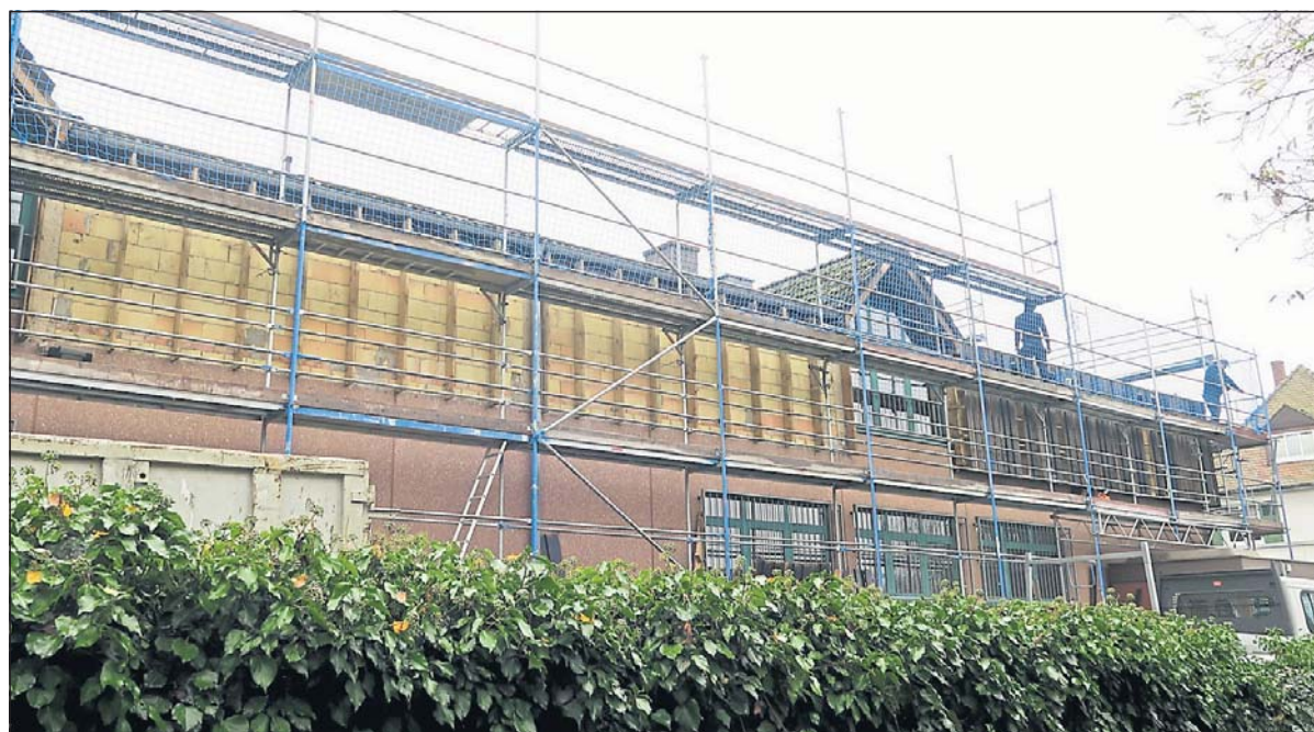
Auf der Nordseite des Gebäudes erfolgt bereits die Demontage der Verkleidung.
