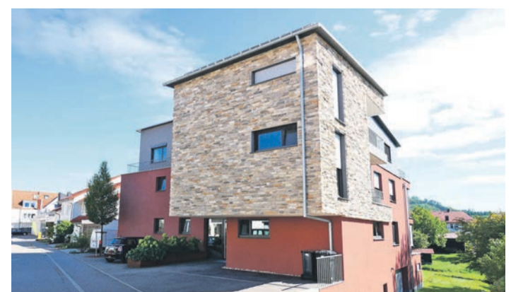
Fassadendämmungen mit WDVS müssen nicht immer verputzt sein. Sie lassen sich auch mit Klinker- oder Natursteinriemchen gestalten. Foto: djdl/puren
