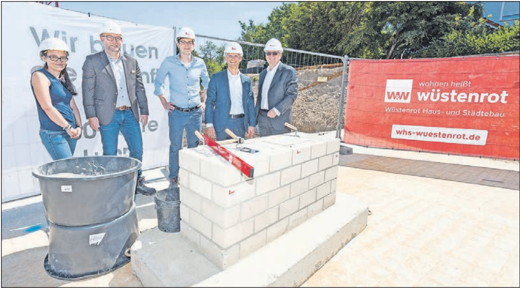
Sie legen den Grundstein (v. l.): Projektleiterin Sabrina Schütt, Bereichsleiter Wohn- und Gewerbebau Alrik von Kolzenberg, Oberbauleiter Frank Naumann, Lupp-Geschäftsführer Michael Fuchs und WHS-Geschäftsführer Marc Bosch. Foto: Sacha Dauphin/WHS
