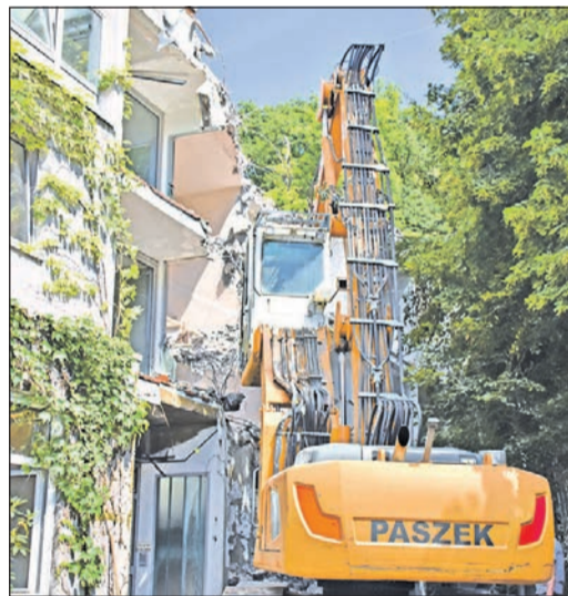
Der neuere Anbau der Villa Victoria wird derzeit abgerissen. Foto: ne
