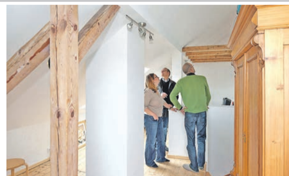
Beim Kauf einer älteren Immobilie empfiehlt es sich, das Gebäude vor Vertragsschluss von einem unabhängigen Sachverständigen auf Schadstoffe abklopfen zu lassen. Foto: djd/Bauherren-Schutzbund
