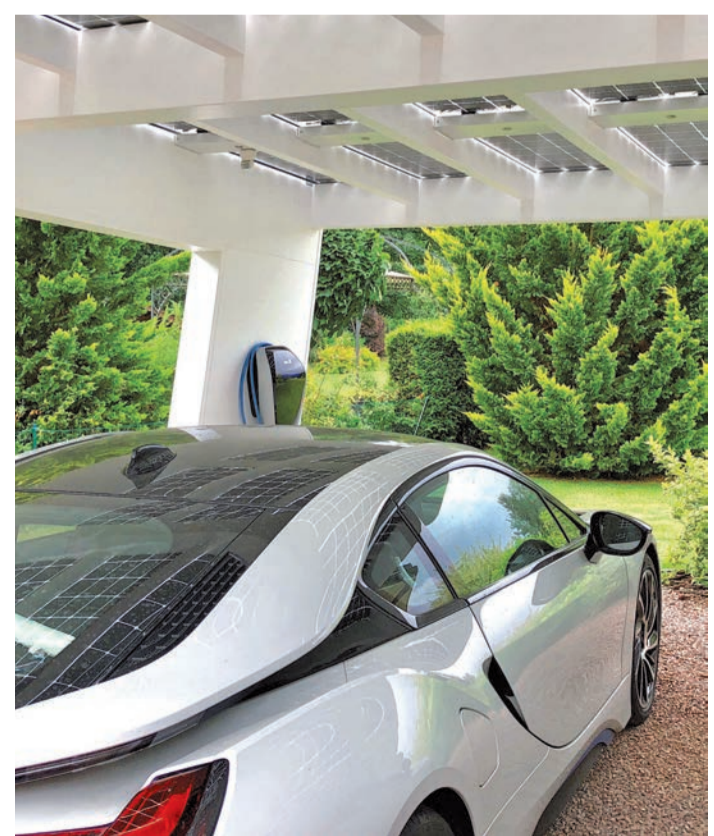
Einmal aufladen, bitte. Das Solardach des Carports gewinnt grünen Strom, um damit direkt das Elektroauto aufzuladen. Foto: djd/www.solarcarporte.de
