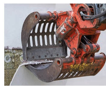
Nach dem Rückbau lassen sich alle Systemkomponenten sortenrein voneinander trennen.
