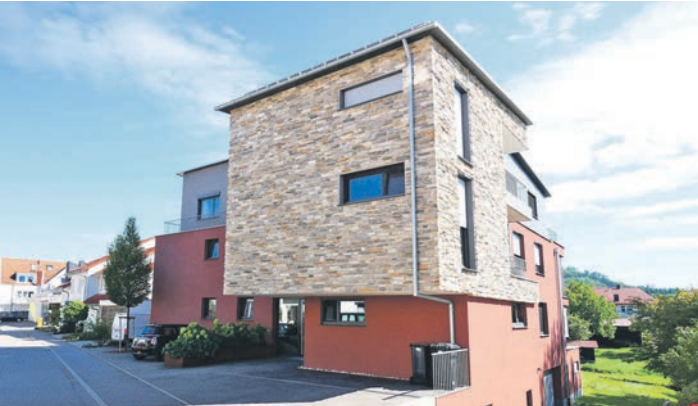
Fassadendämmungen mit WDVS müssen nicht immer verputzt sein. Sie lassen sich auch mit Klinker- oder Natursteinriemchen gestalten. Foto: djd/puren
