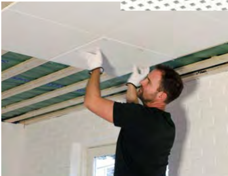
Die gelochten Gipsplatten werden mit passend lackierten Spezialschrauben befestigt.
