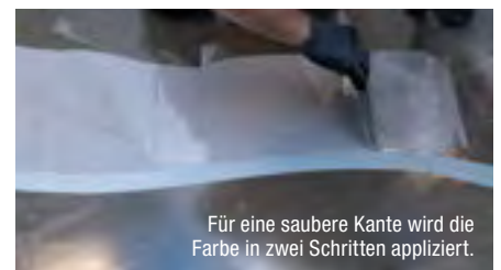
Im ersten Schritt entsteht eine elastische, glatte PU-Verlaufsbeschichtung.
