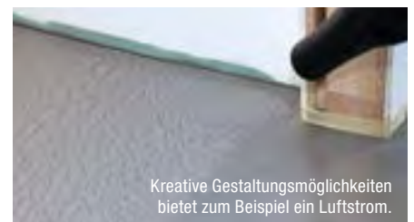
Für eine saubere Kante wird die Farbe in zwei Schritten appliziert.
