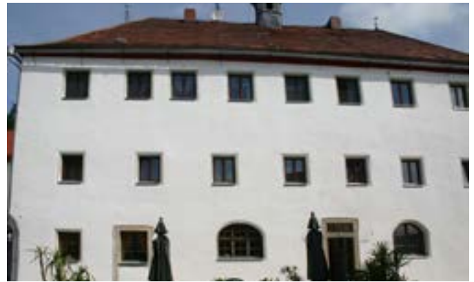
Sanierputze verleihen einer ramponierten Fassade neuen Glanz und sicheren Schutz.
