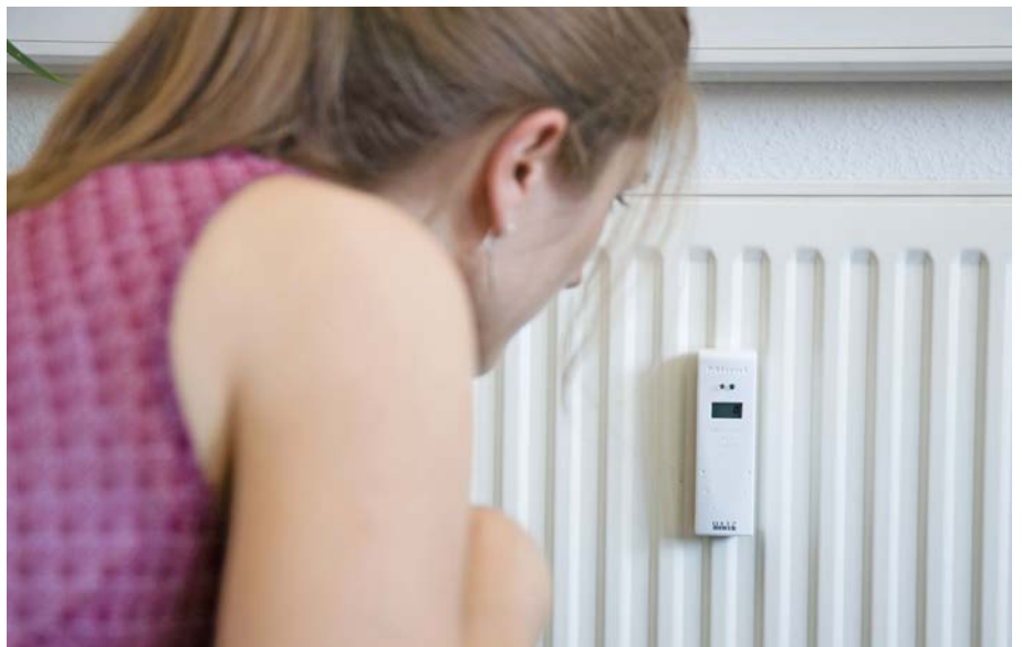
Wenn der Energieverbrauch regelmäßig mit einem modernen Fernablesesystem erfasst wird, können die Bewohner besser verstehen, wie die Energiekosten zustande kommen.
