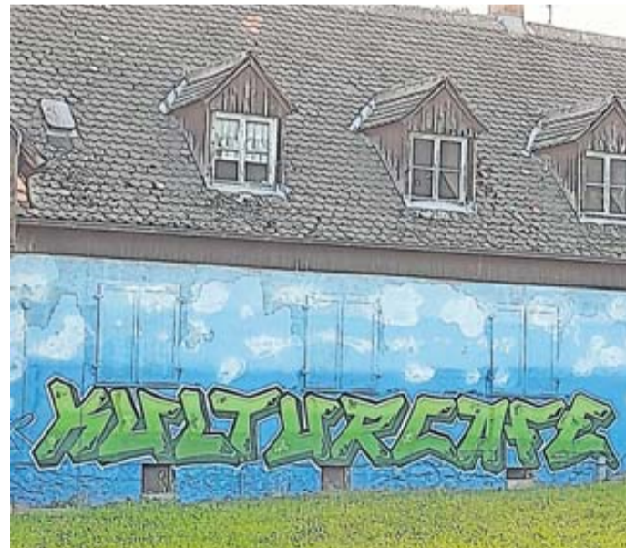
Die Fassade des Gebäudes nimmt neue Gestalt an.
