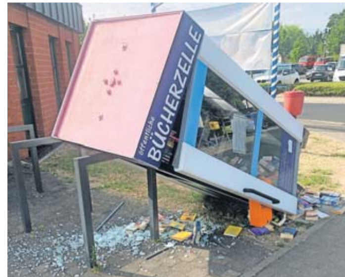
Die Zelle wurde aus der Bodenverankerung gerissen und umgeworfen.
