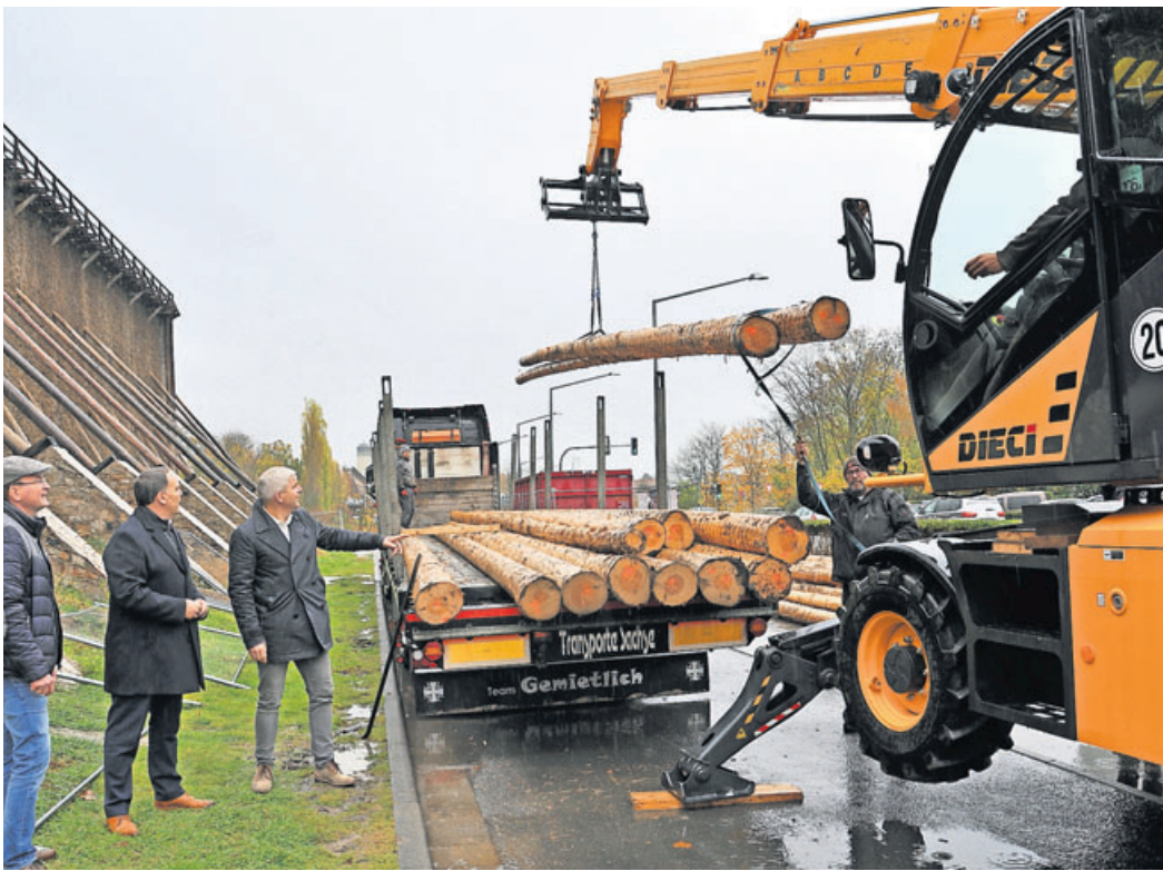
Wie die Sanierung der Gradierbauten I und III voranschreiten, davon machen sich Bürgermeister Klaus Kreß (Mitte), Steffen Schneider (Fachbereichsleiter Kur- und Servicebetrieb, rechts) und Volkmar Dörn (Fachdienstleiter Kureinrichtungen und Therme) ein Bild vor Ort.
