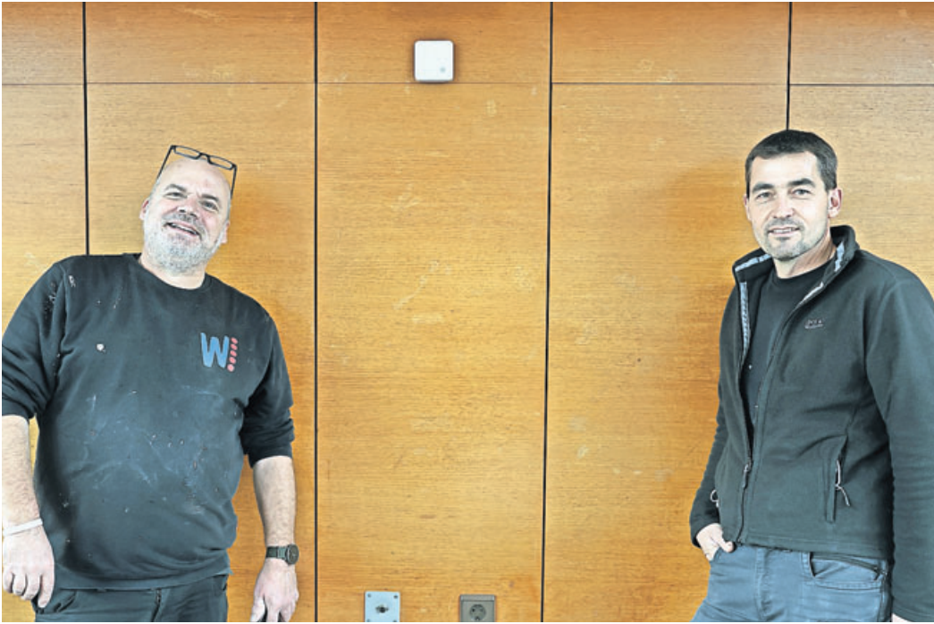
Objektbetreuer Markus Marx und Timo Rilk an einem der neu installierten Sensoren.
