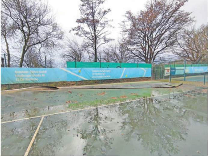
Der Wind hat den verschraubten Belag der Plätze abgehoben.
