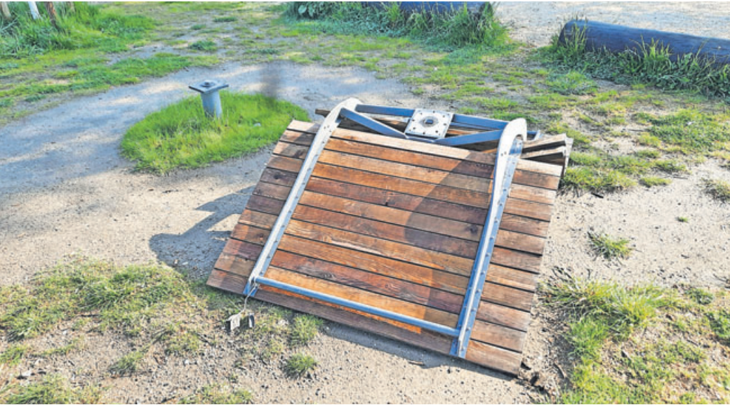
Der gesamte Schaden am Nidda-Ufer wird auf 10.000 Euro geschätzt.
