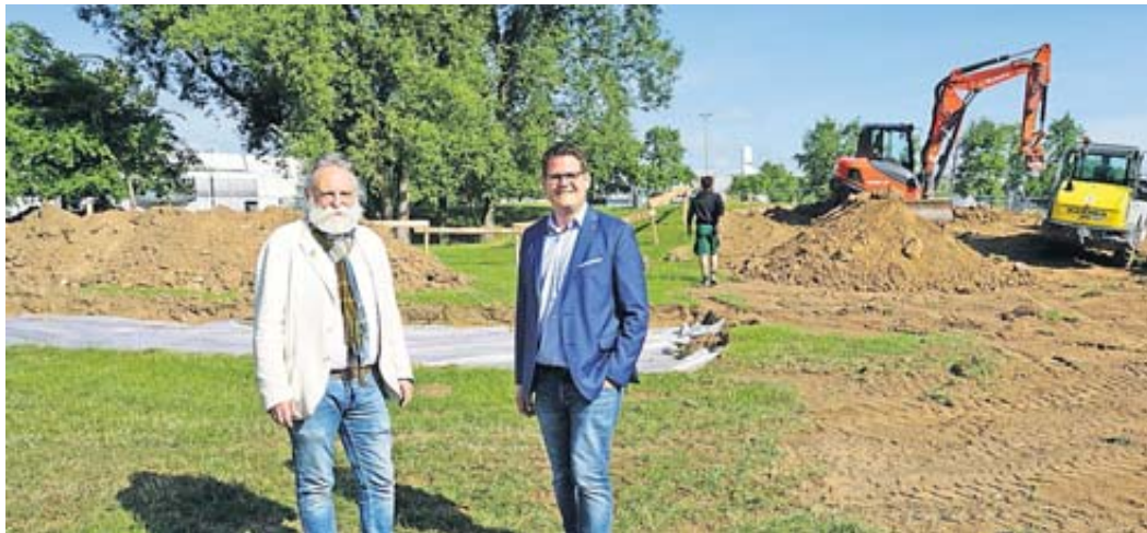
Erster Stadtrat Sebastian Wysocki und Kulturamtsleiter Claus-Günther Kunzmann vor Ort beim Baubeginn des Generationenparks.
