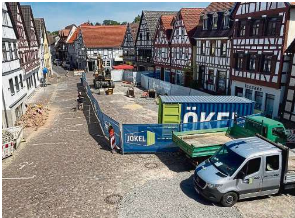
Voraussichtlich noch bis ins Frühjahr 2023 hinein wird unter und auf dem Marktplatz in Windecken gearbeitet – das bedeutet teilweise heftige Umsatzeinbrüche für umliegende Geschäfte.
